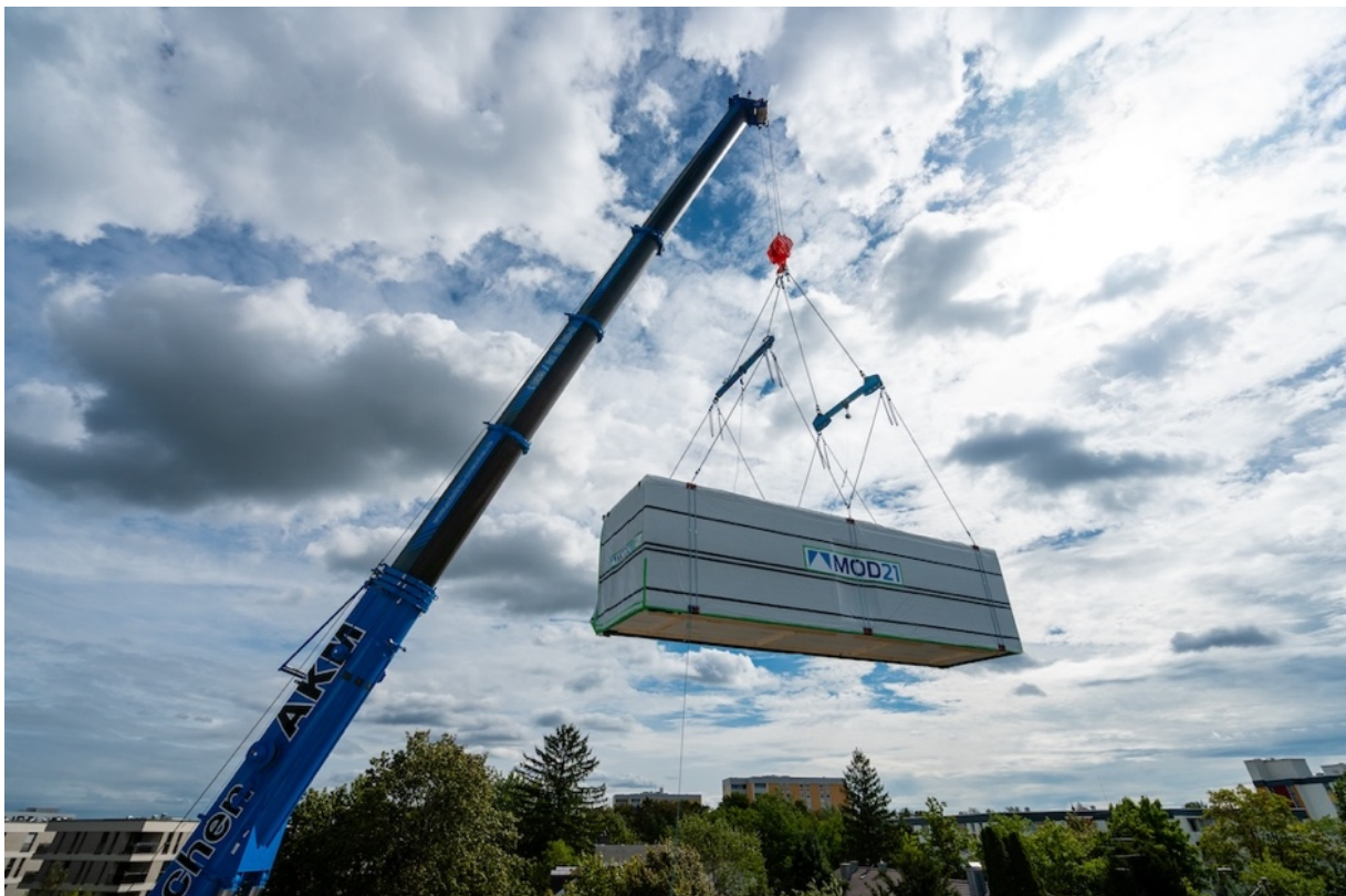
Abb. 1: Alternative zum konventionellen Bau. Die Holzmodule von MOD21 werden im Werk vorgefertigt und ausgebaut zur Baustelle geliefert – dies bedeutet eine enorme Zeitersparnis für Bauherren.
